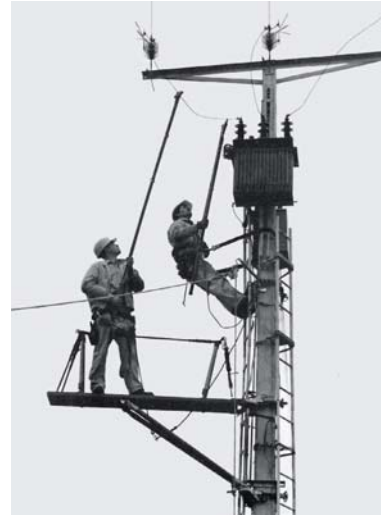
Slika 1. Zamjena NN potpornih izolatora pomoću bambusovih štapova (1960) i rad na udaljenosti s izolacijskim štapovima (1966) u Francuskoj [3]
